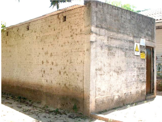
Arriba: Depósito de plaguicidas. La marca oscura en las paredes indica el nivel alcanzado por el alud ocurrido en febrero de 2009.
