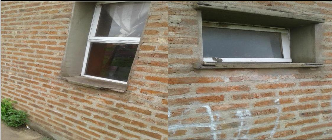
Deterioro por humedad en los vanos de las aberturas por falta de goterones que dejan al descubierto los hierros
