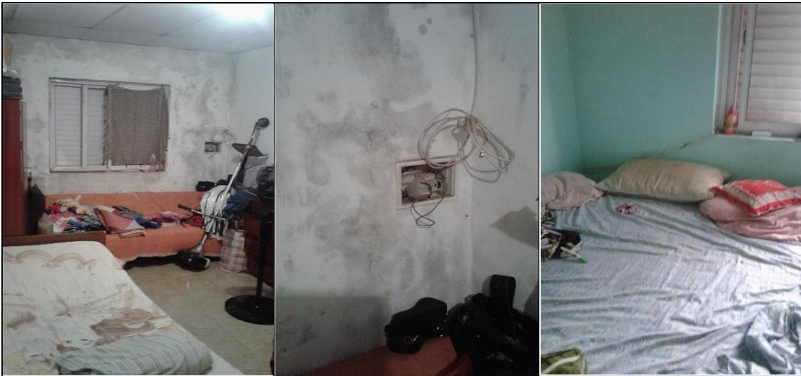
Paredes exteriores con rajaduras y sin aislación que permiten el ingreso de humedad y el riesgo de choque eléctrico
