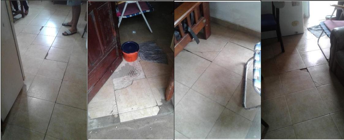
Hundimiento de piso por mal apisonamiento del terreno y ruptura o desprendimiento de cerámicos en el solado
