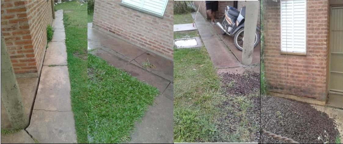
Hundimiento de piso por mal apisonamiento del terreno.
