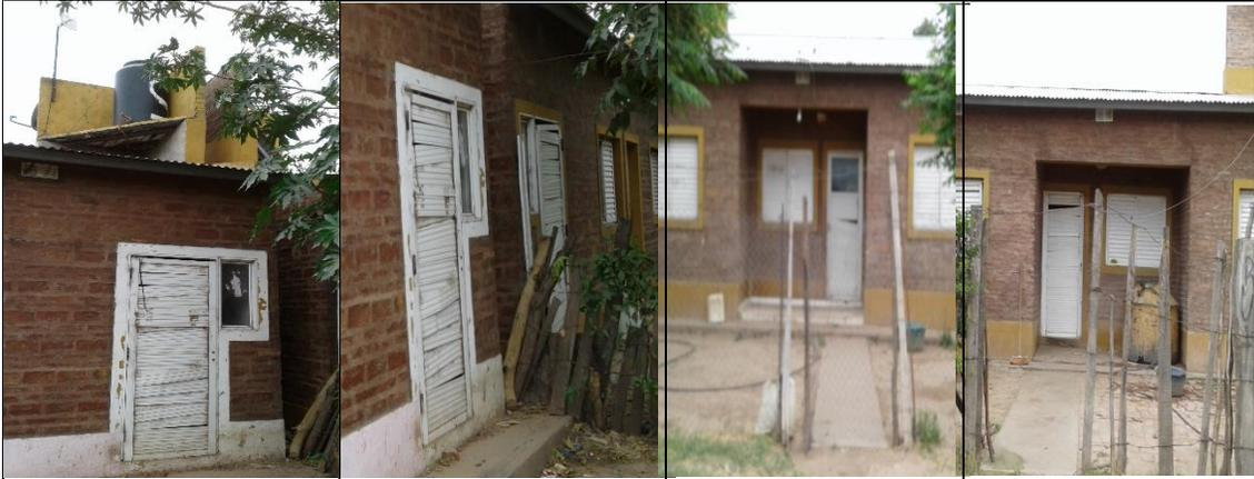
Puertas exteriores que se desarticulan y desarmar. No cumplen la función de seguridad y aislación exterior.
