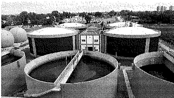
Fig. 1 PBSD - Vista Almacenadores lodo digerido y digestores
