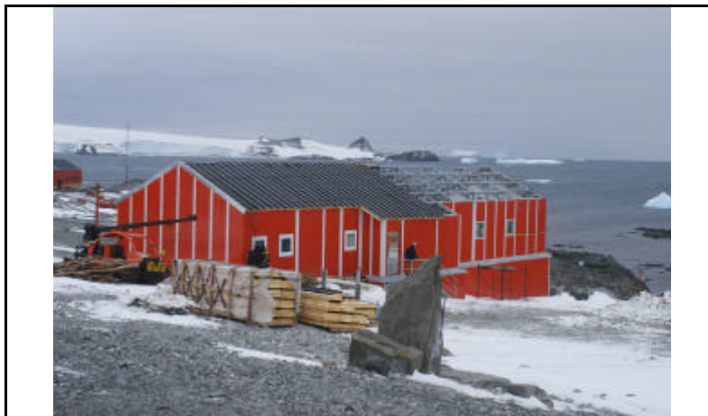
Esc. N° 38 "Base Esperanza", finalizando construcción.
