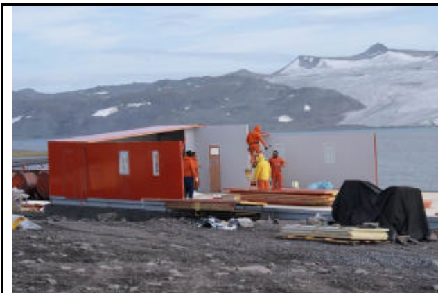
Alojamiento de Base Jubany en construcción.
