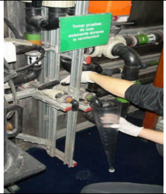
Extracción de lodos de la planta.
